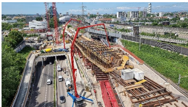
Entflechtung Basel–Muttenz: Bau Donnerbaumbrücke im Mai 2022
