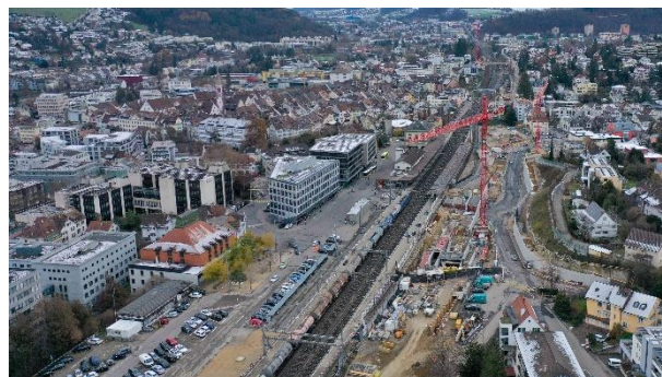
Vierspurausbau Liestal: Ausbau Perronanlage im Dezember 2020
